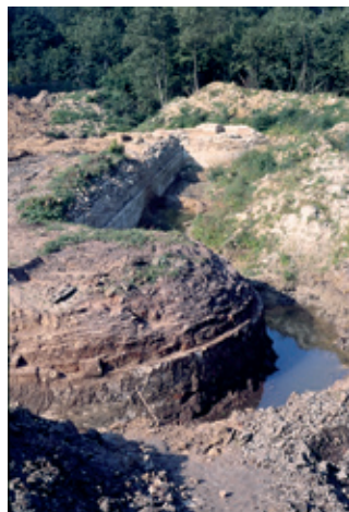
De muren van Jonkholt zijn in baksteen opgetrokken en aan de buitenzijde bekleed met mergel. Dit heet een mergelparement.
