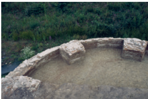
Op deze foto zie je dat er aan de binnenzijde van de muren funderingsblokken voorzien zijn om beter een neergang te construeren.
